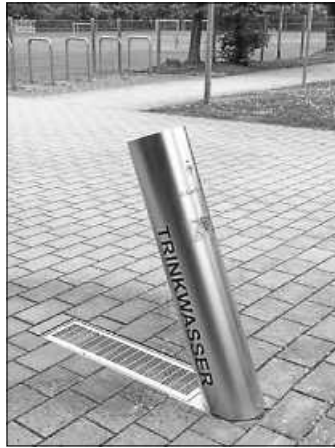
Trinkwasserbrunnen am Breitwiesenstadion
